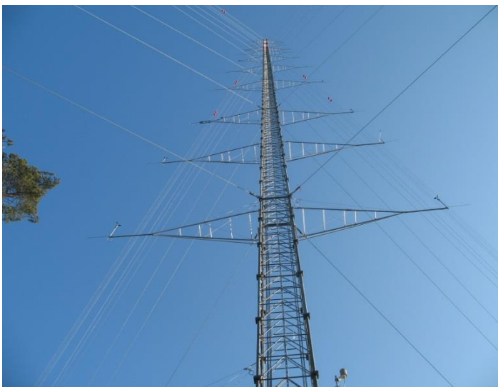
Figure 1: Mât de mesure de 200 m de l'institut Fraunhofer IWES de Cassel, avec consoles, capteurs et haubans.
