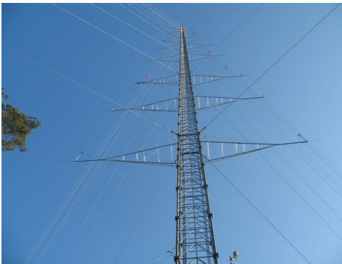
Abbildung 1: 200 m Forschungsmessmast des Fraunhofer IWES Kassel mit Auslegern, Sensoren und Abspannungen.
